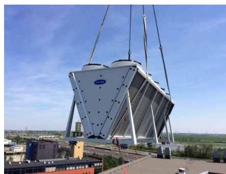
Plaatsing nieuwe, energiezuiniger koelmachines op dak ziekenhuis Leiderdorp
